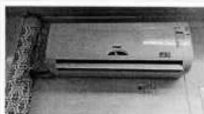
Admiral 18 mil BTU upa de Itaguaí o mesmo foi feita a lavagem completa e foi usado 200 ml de zenite da 14/11
