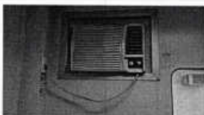
Admiral 18 mil BTU upa de Itaguaí o mesmo foi feita a lavagem completa e foi usado zenite 200 ml data 14/11
