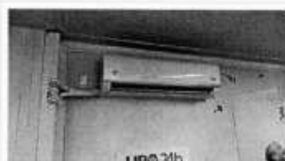
Admiral 18 mil BTU upa de Itaguaí o mesmo foi feita a lavagem completa e foi usado 200 ml de zenite da 14/11
