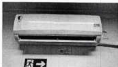
Springer 12 mil BTU upa de Itaguaí o mesmo foi feita a lavagem completa e foi usado 200 ml de zenite data 14/11
