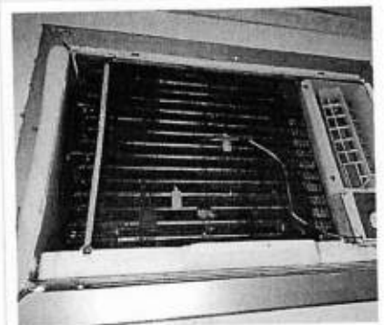
foi trocado o termostato da sala coordenação/diretoria
