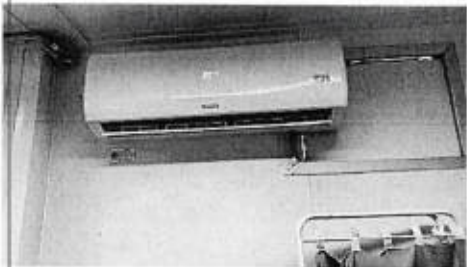
APARELHO CONSULTORIO 4 (NÃO FUNCIONA COM O CONTROLE )
