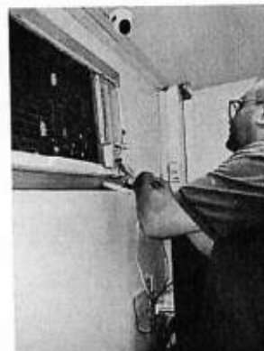
troca do termostato sala - coordenação/ diretoria
