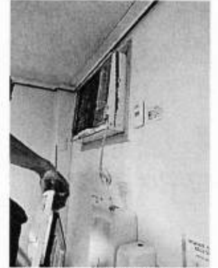
COLOCADO O CAPACITOR NO APARELHO .
