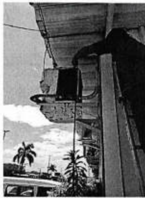
limpeza preventiva condensadora piso teto recepção
