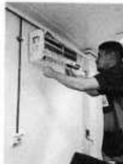
Filtro higienizado e aparelho funcionando
