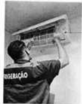
Filtro sendo retirado para Higienização
