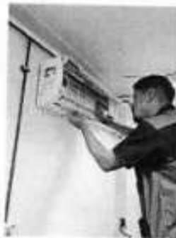
retirando filtro para Higienização
