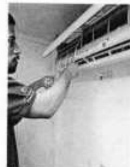
Filtro higienizado e aparelho funcionando
