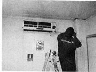
troca do termostato sala - coordenação/diretoria
