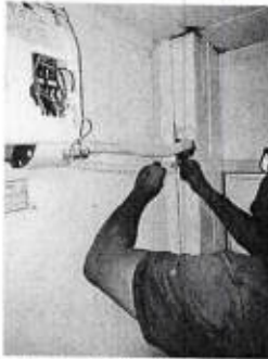
desentupimento e insolamento com fita PVC e limpeza preventiva Sprinter local corredor sala amarela
