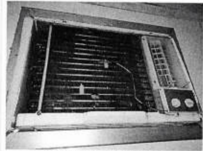
foi trocado o termostato da sala coordenação/diretoria
